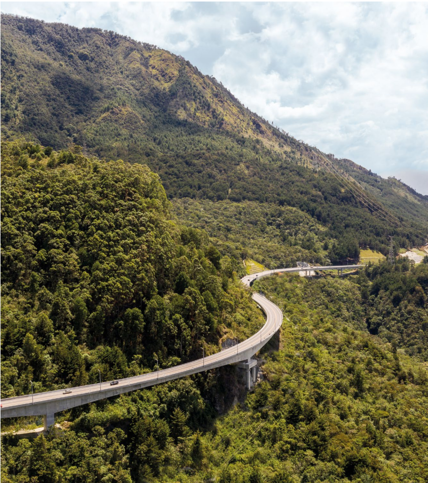
Túnel de Oriente Antioquia
