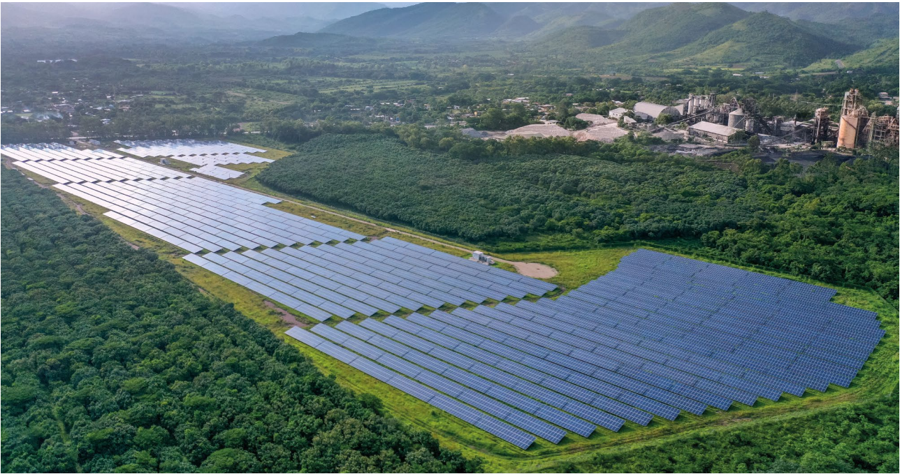
Celsia Solar Comayagua Honduras
